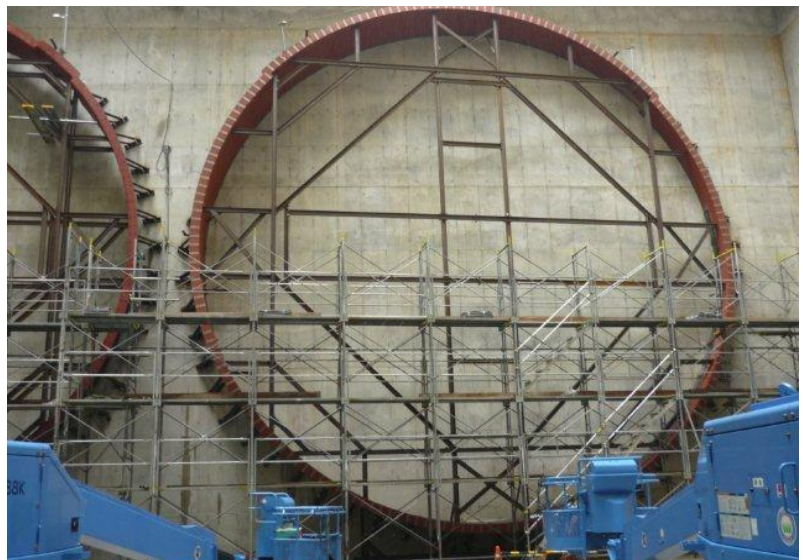
エントランス据付状況 (直径 \phi 12.86m)
