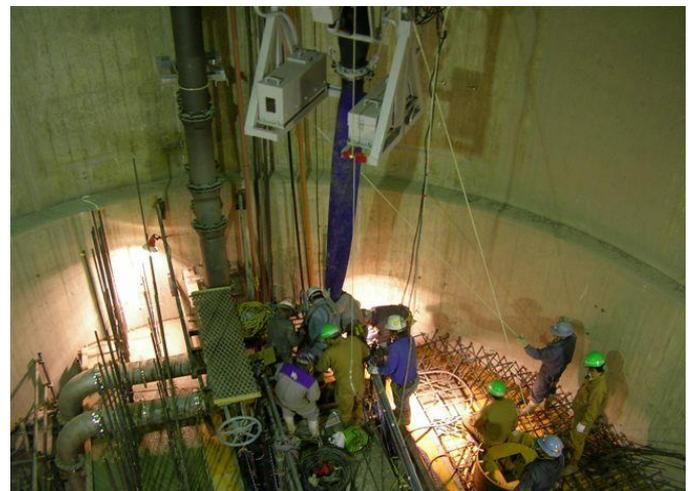
立坑内のコンクリート打設状況
