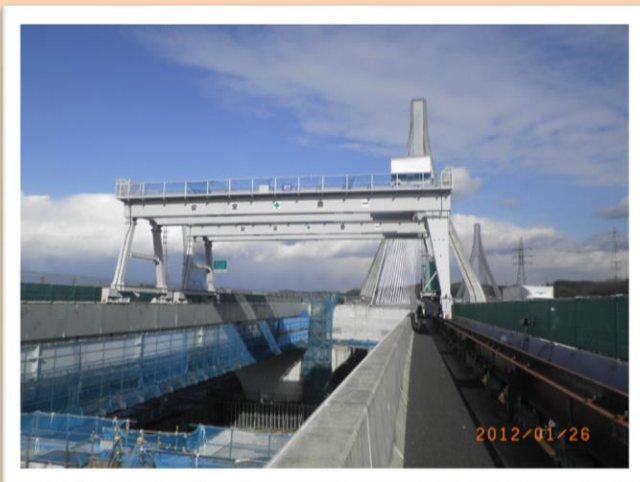
30t橋形クレーン-クラブ式SP20.5m
