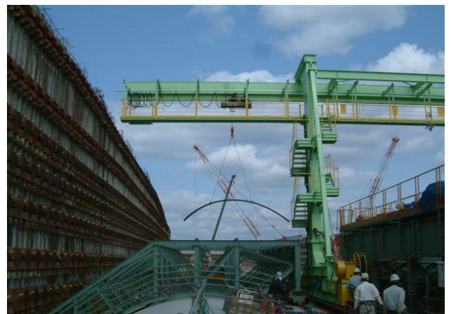
8m張り出し部
