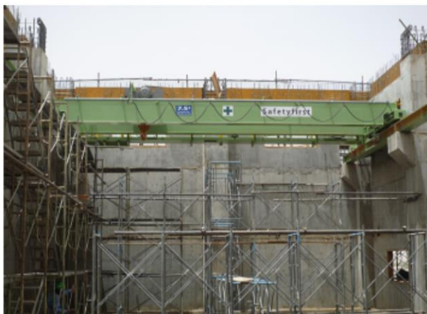
7. 5t 天井クレーンクラブ式SP9. 9m
