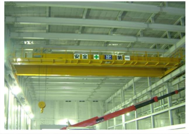
15t 天井クレーンクラブ式SP15.3m
