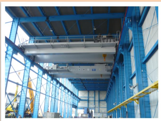
30t天井クレーン-クラブ式SP12.1m
