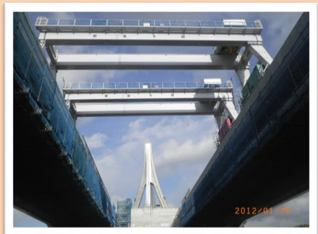
30t橋形クレーン-クラブ式SP20.5m
